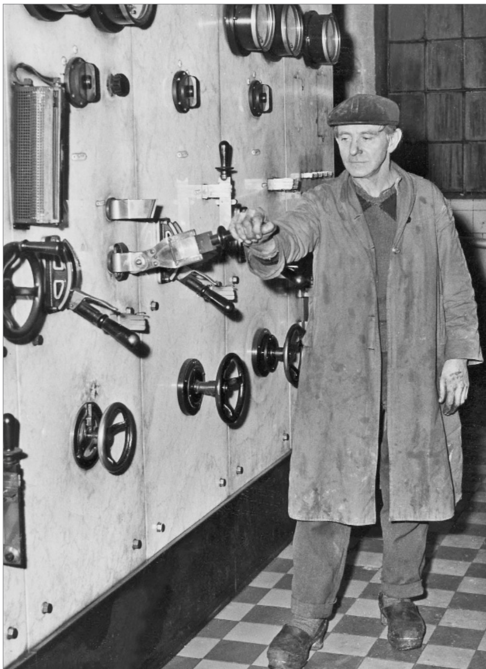
Mekaniker Søren Larsen kontrollerer elektricitetsværket.
